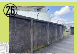
②⑥ 高栄産業の外壁 火薬廠の塀が残る。
